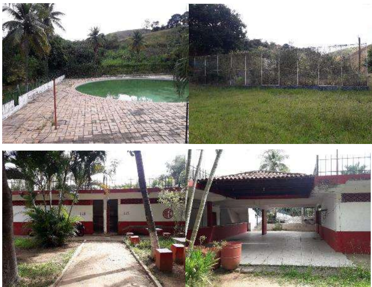
Figura 17 – Fotos do terreno
