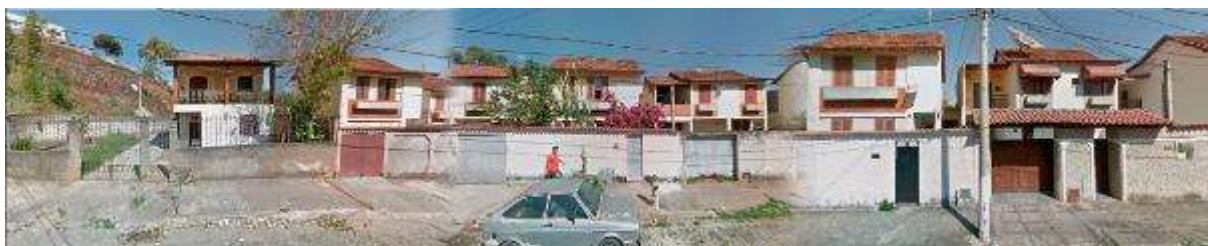
Figura 22 – Fachada parte baixa
