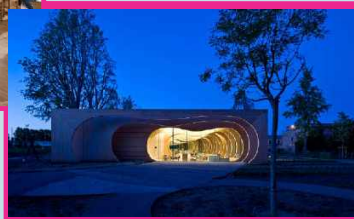
Creche em guastalla
