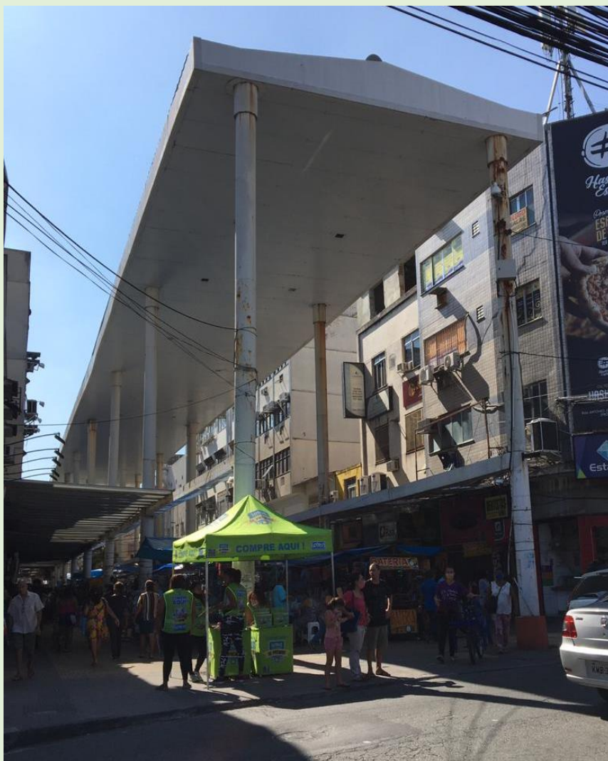
Figura 19. Cobertura vista do observador.
