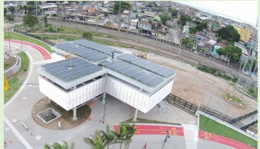
Figura 11. Edifício Multiuso Sustentável
