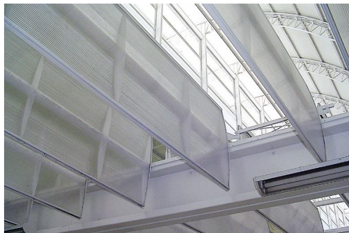
Figura 47: Forros basculantes abertos.
