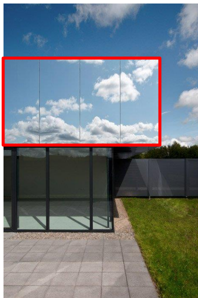
Figura 33: Platibanda Espelhada.
