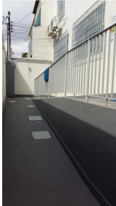
Figura 75: Entrada com rampa
