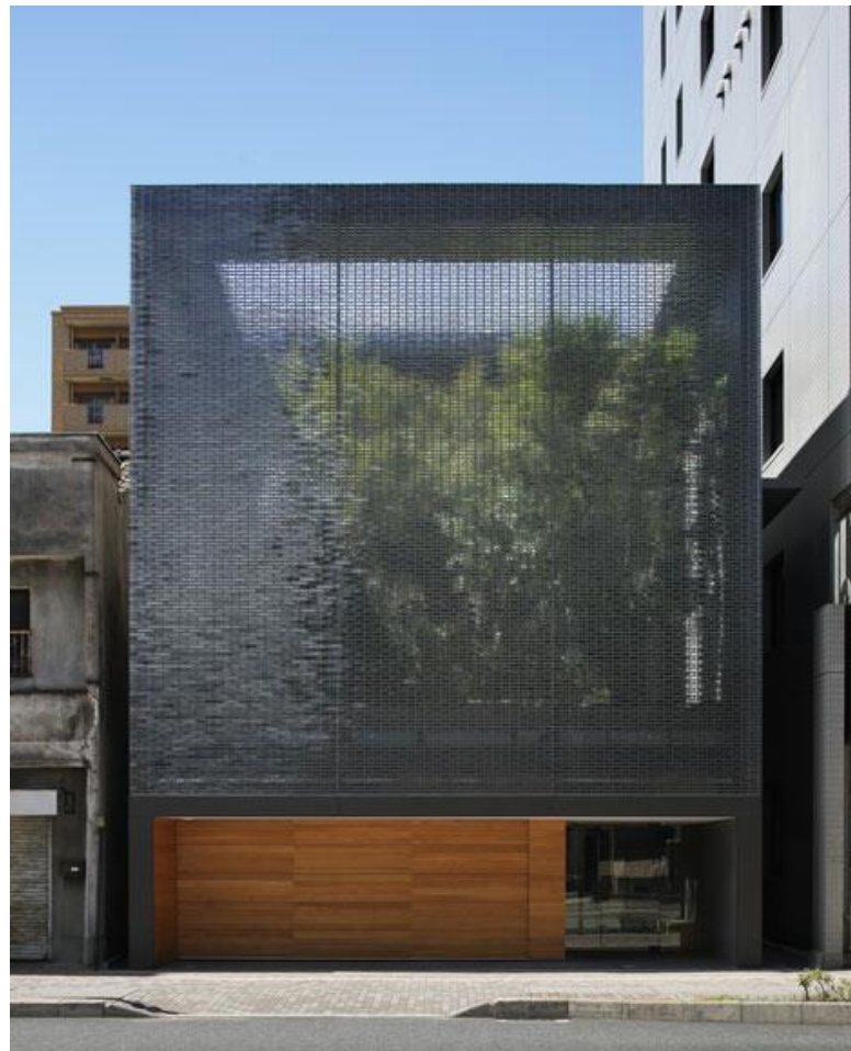
Figura 48: Fachada Sul. Fonte: Site Dezeen online (2016)
