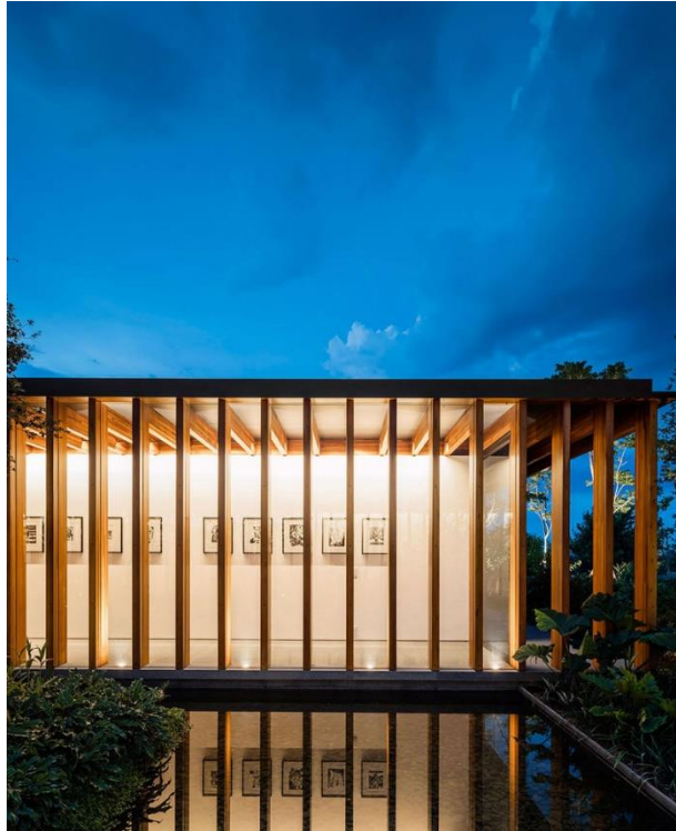
Fotografia 17. Sequência de pórticos Residência OJ.
