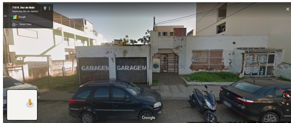
Figura 2 – Fachada Frontal Sudoeste
