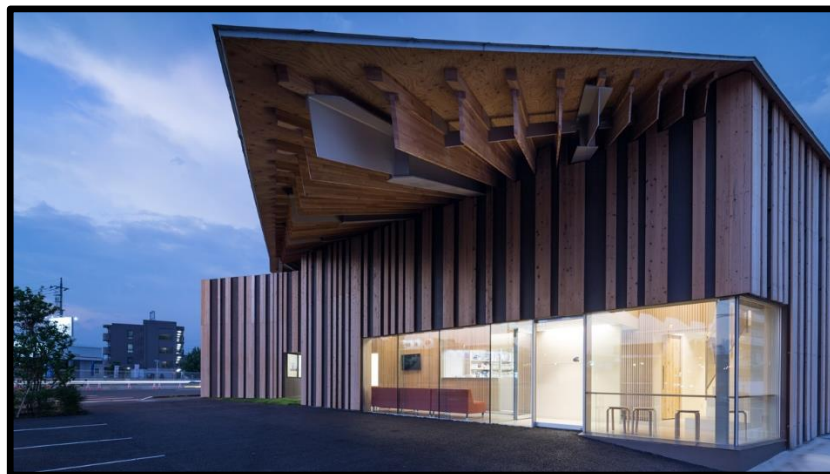
Figura 30 - Fachada com destaque no telhado
