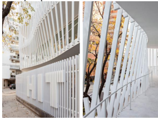
Imagem 55. Composição da fachada com tubos metálicos - HIT 3.
