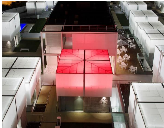
Figura 30 – Cobertura das unidades habitacionais.
