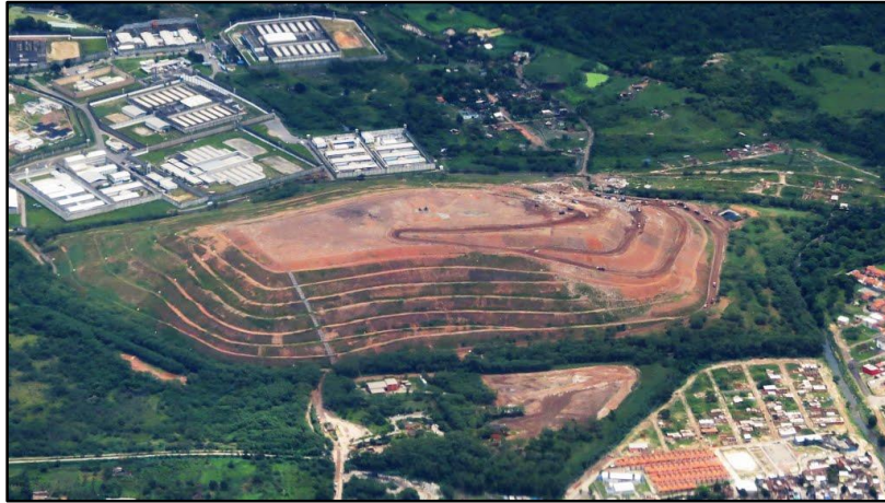
Figura 4 - Vista aérea do Aterro de Gericinó
