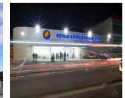
Fig. 38 – ADVEC, tem sua tipologia e elementos de fachada replicados em cada sede
