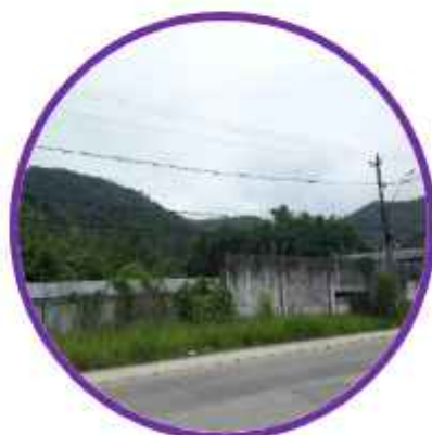
Fig. 60 Vista do Terreno de Projeto, atualmente protegido com muro de alvenaria e tapumes, sendo acessado periodicamente para limpeza. O Terreno já foi terraplanado anteriormente.
