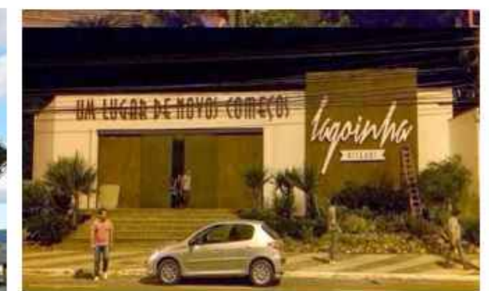
Fig. 40 – Igreja Batista Lagoinha em Niterói – RJ, adaptação funcional de uma antiga casa de shows
