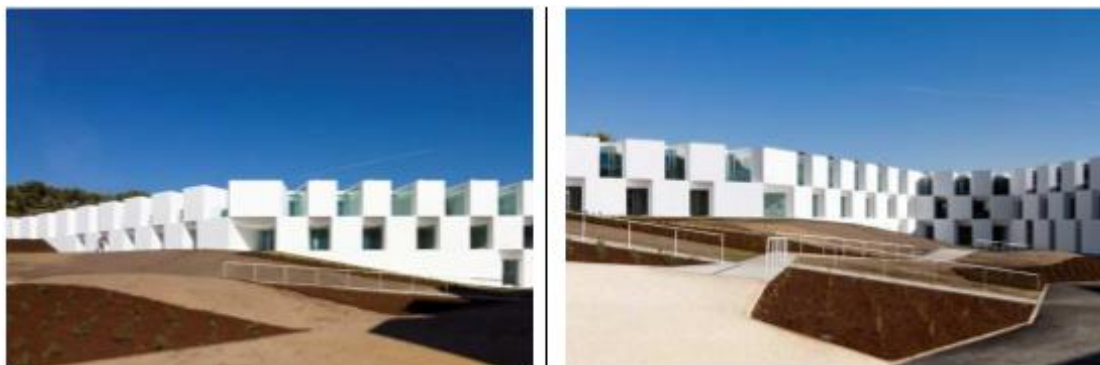
Figura 5: Fachada do condomínio
