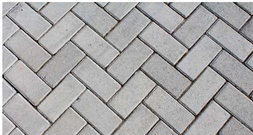
Figura 38: Figura ilustrativa bloco de concreto intertravado.
