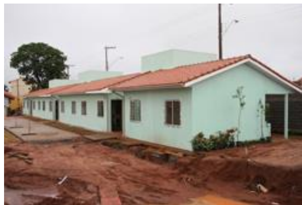
Figura 31 – Casa finalizada com placas cimentícias e pinturas texturizadas
