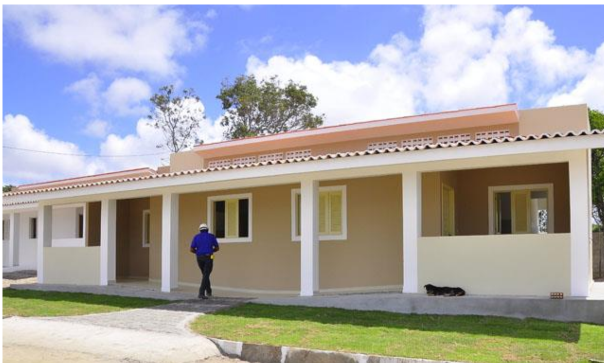
Figura 47 – Estrutura da Residência
