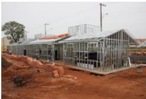
Figura 30 – Construção das casas com sistema estrutural steel frame
