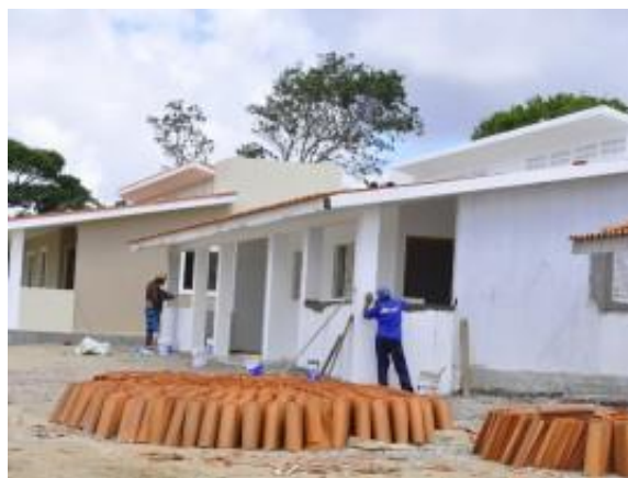
Figura 49 – Estrutura da Residência
