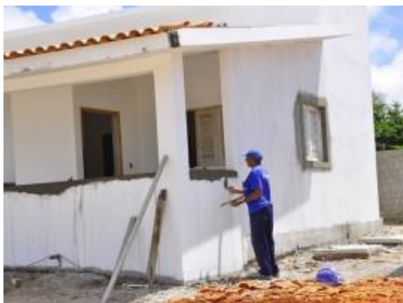
Figura 48 – Estrutura da Residência
