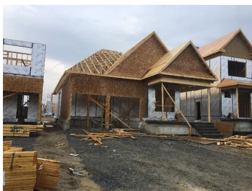
Figura 1 - Construindo em Wood Frame
