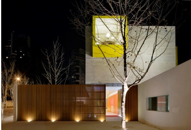
Figura 26 – Entrada da creche. Fonte: ArchDaily
