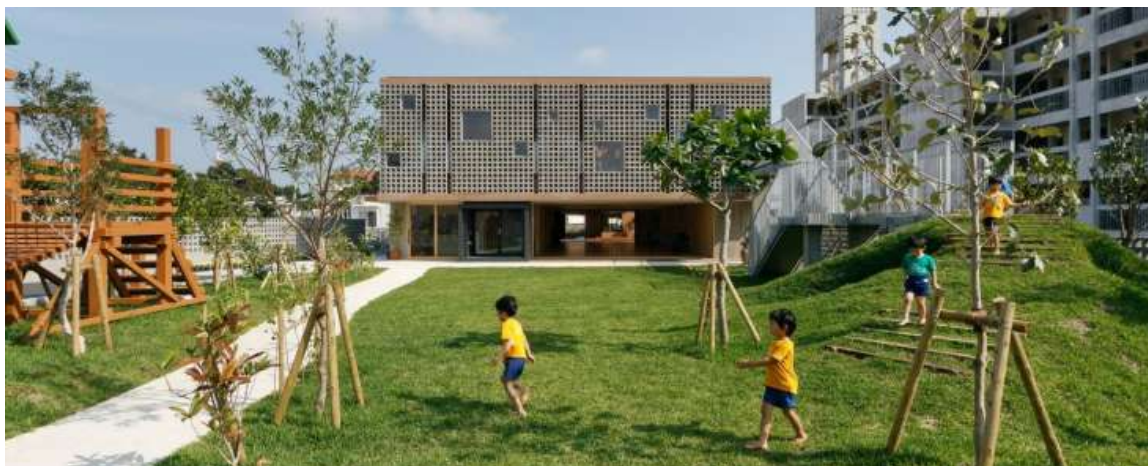
Figura 33 - Fachada Berçário e Jardim de Infância Hanazono
