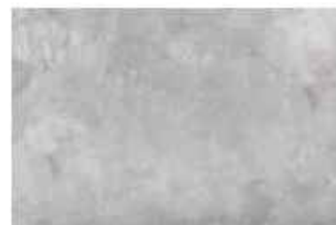
FIGURA 13. Concreto armado e polido.
