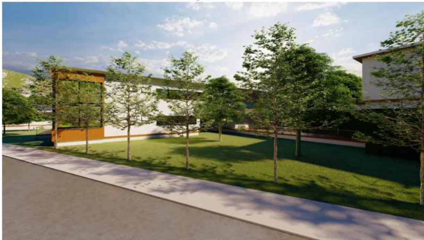
FIGURA 27. Visão frontal do núcleo de tratamento e triagem.
