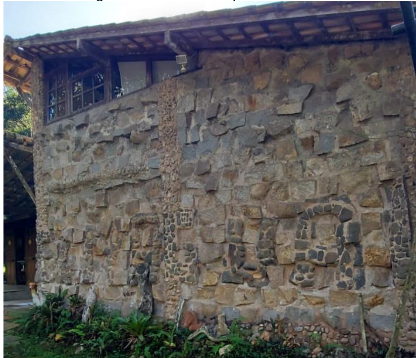
Figura 43 – Parede de pedra do terreno
