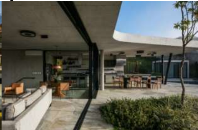
Figura 8 – Área interna e externa casa LLF
