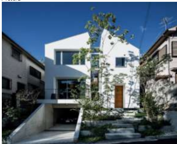
Figura 5 –Fachada residência Crevasse Haus
