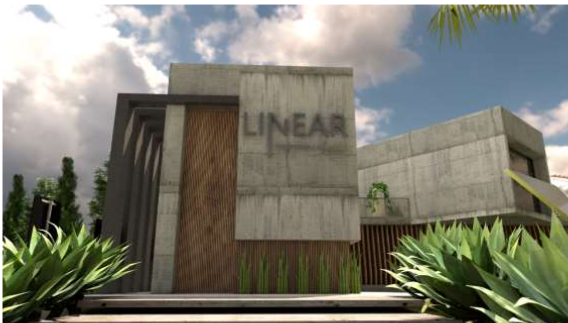
Figura 29: Fachada frontal da edificação.
