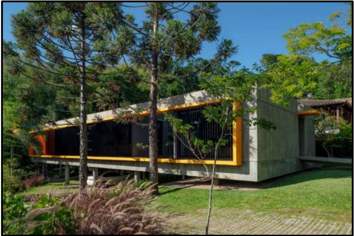
Figura 38: Fachada do Escritório Lineastudio Arquiteturas.
