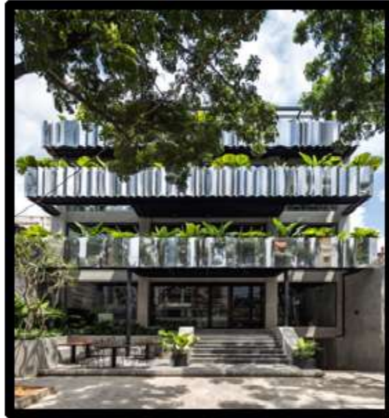
figura 7: fachada frontal da edificação
