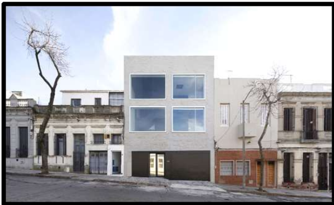
Figura 14: fachada frontal da edificação
