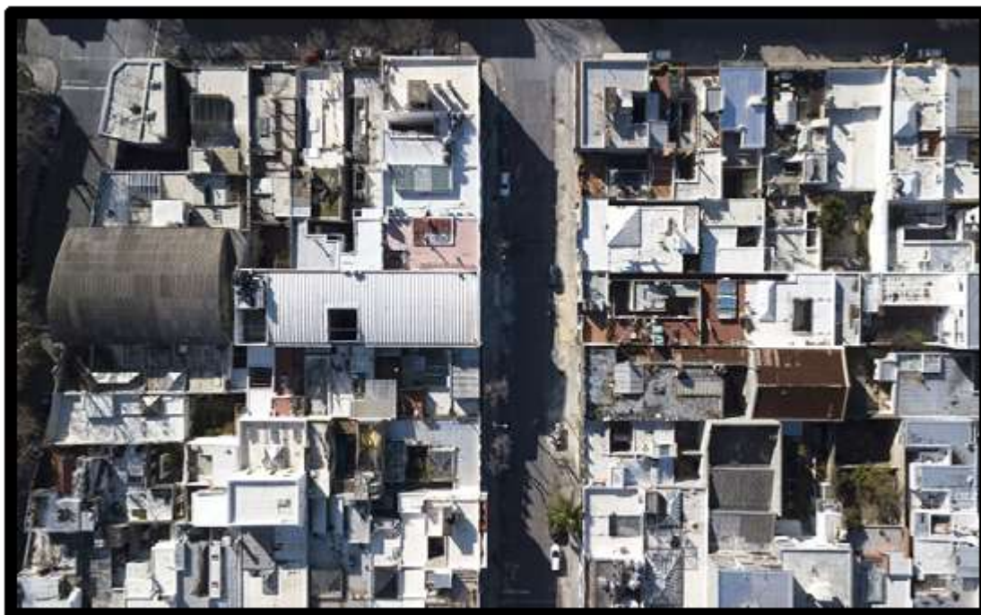
Figura 12: vista superior do escritório
