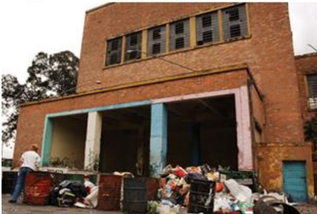
Figura 27 – Edifício incinerador desativado
