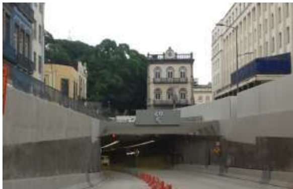
Figuras 87: Início do túnel
