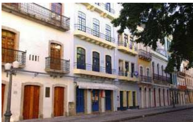
Figura 7: Revitalização no Centro de Recife Fonte: Revista desafio's – 2013
