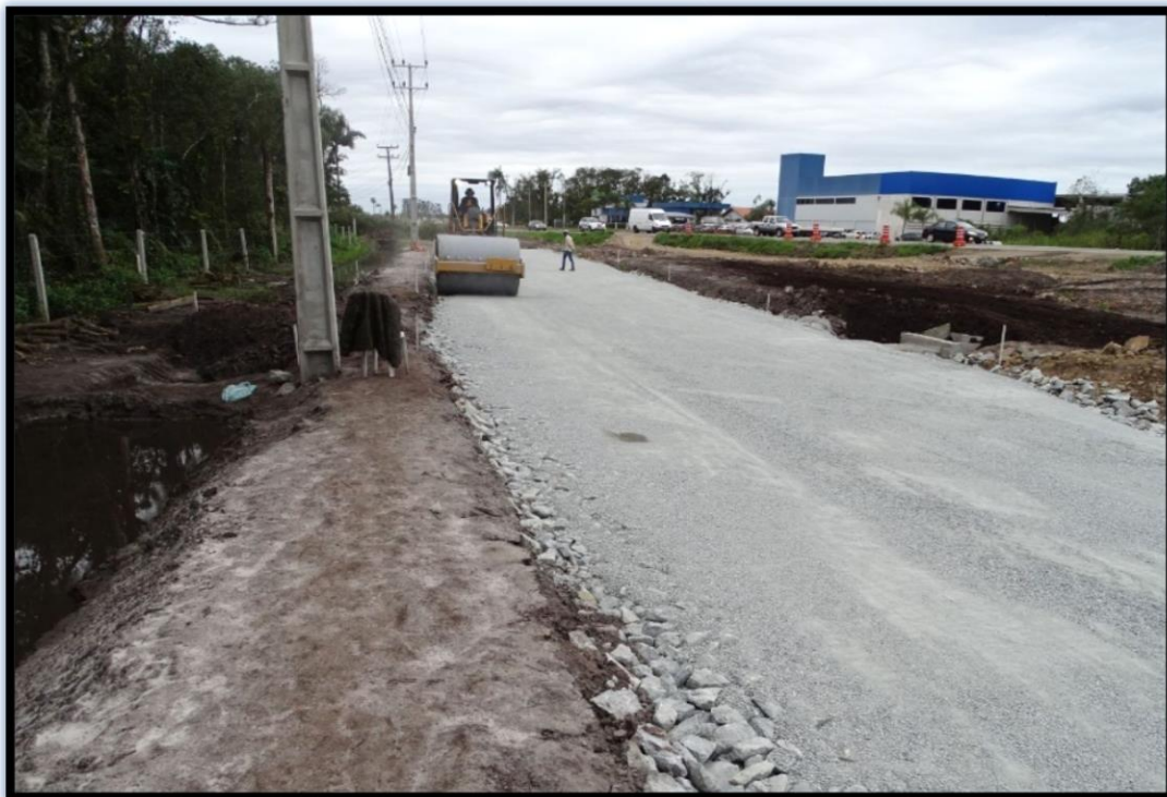
Figura 9: Preparação da base
