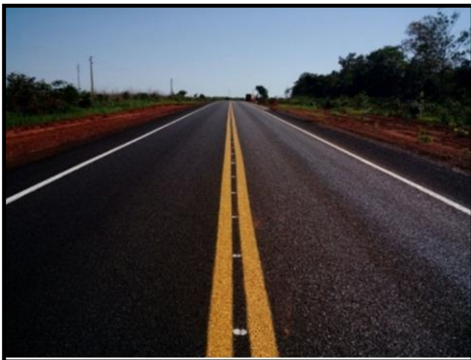
Figura 3: Rodovia Pavimentada com CAUQ
