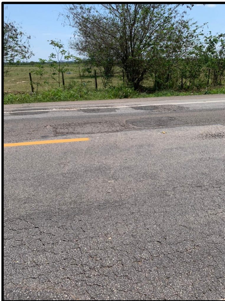
Figura 19: Patologia Desgaste
