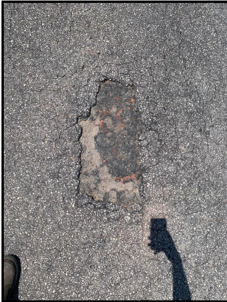
Figura 33: Patologia Panela.
