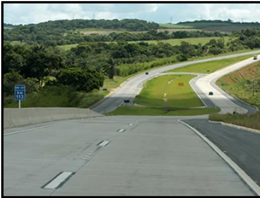
Figura 5: Rodovia Pavimentada com PCS
