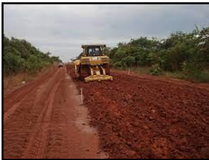
Figura 7: Reforço do Subleito
