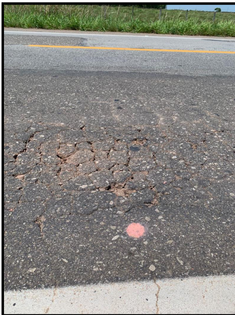
Figura 23: Patologia Desgaste.
