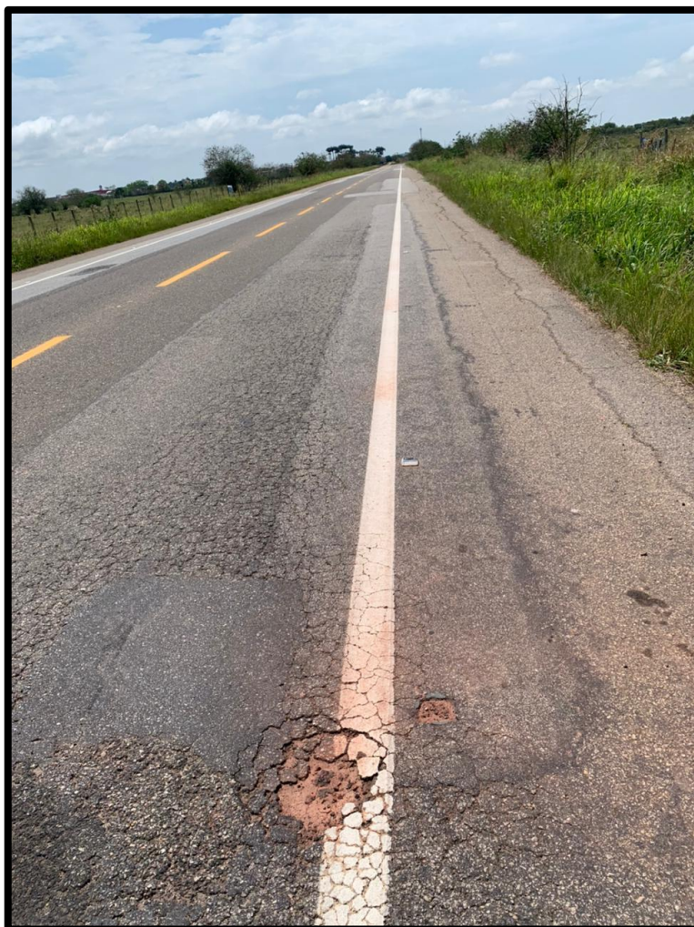
Figura 20: Patologia Panela (buraco)
