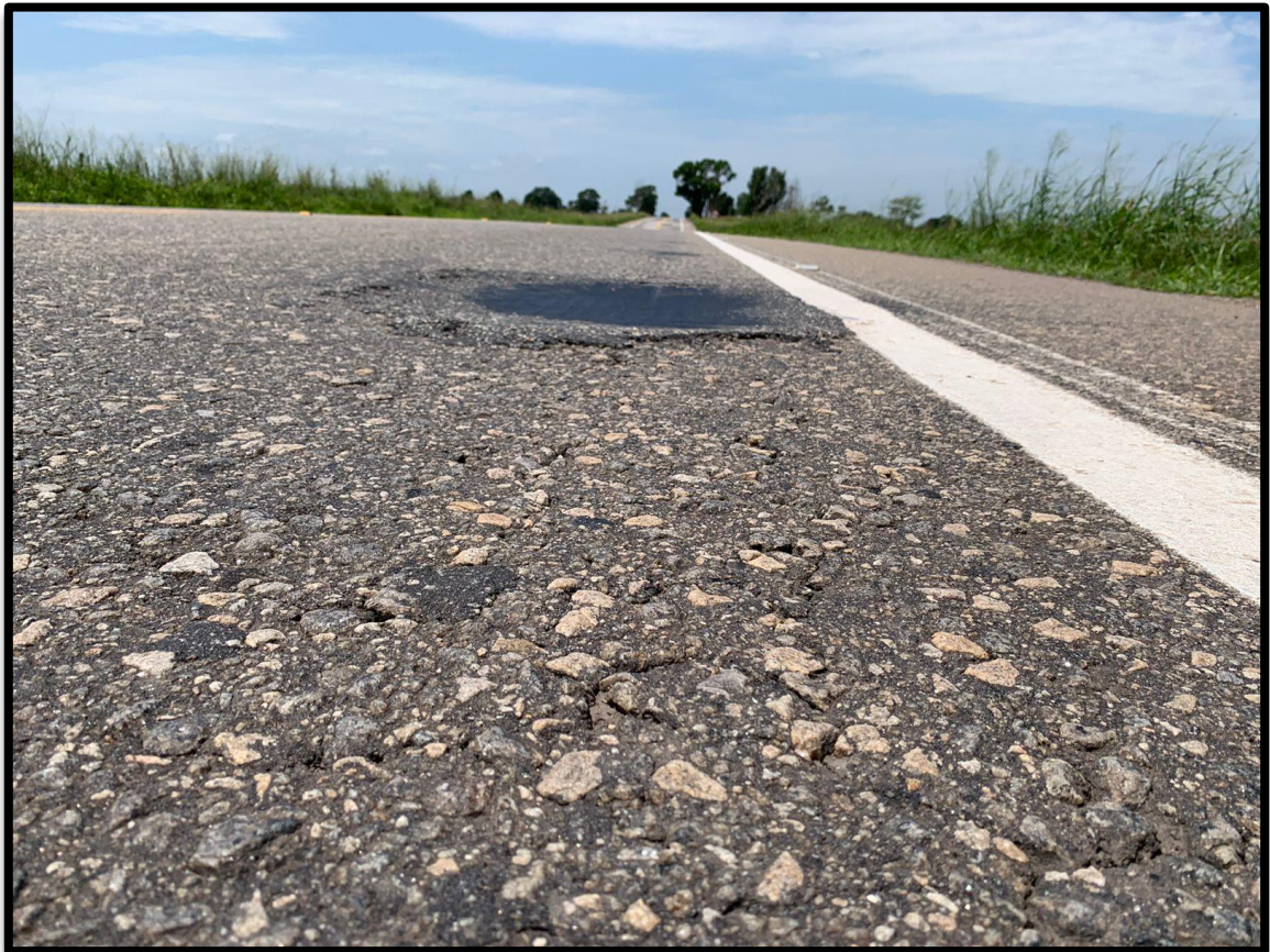
Figura 37: Patologia Panela
