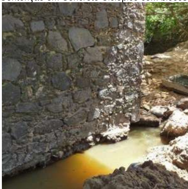
Figura 6: Contenção em Concreto Ciclóptico com blocos evidentes.
