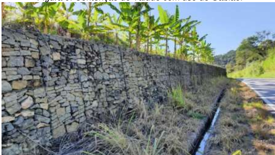
Figura 9: Contenção de Talude com uso de Gabião.
