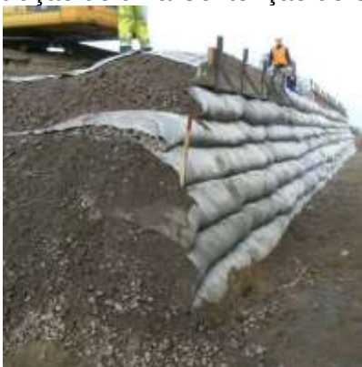
Figura 1: Construção de uma Contenção de Solo Reforçado.
