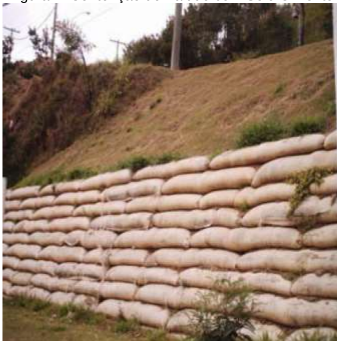
Figura 7: Contenção de Talude com Solo Cimento.
