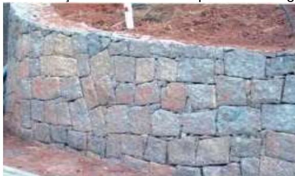
Figura 3: Contenção de alvenaria de pedra sem argamassa.
