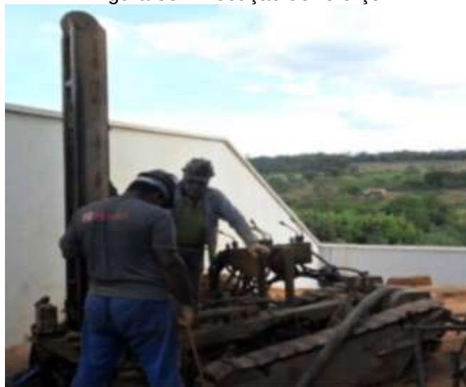
Figura 35: Execução do reforço.
