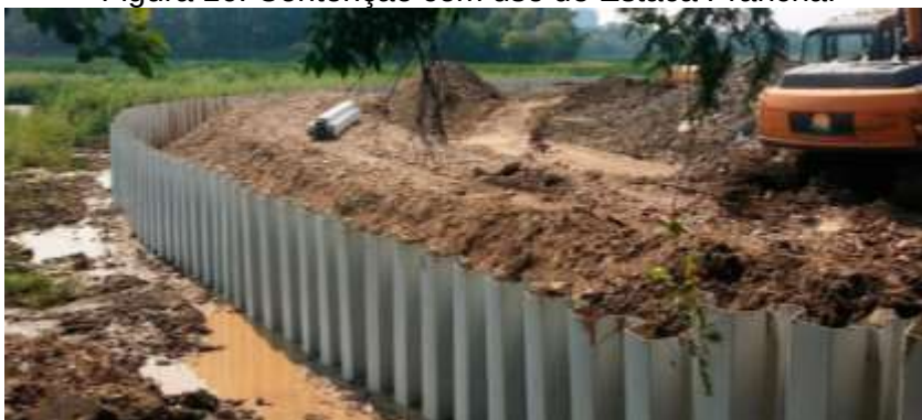
Figura 16: CONTENÇÃO COM USO DE ESTACA PRANCHA.
