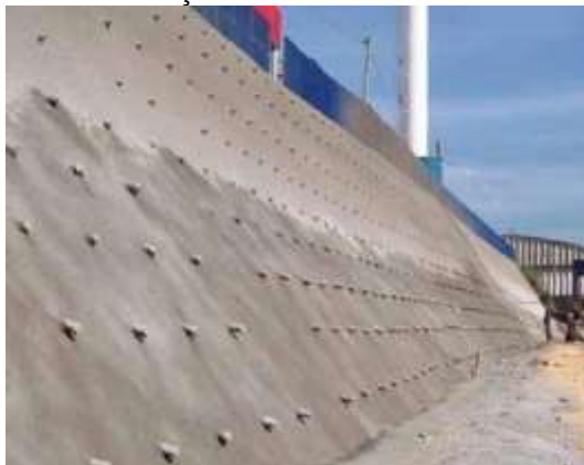
Figura 13: Contenção Com Uso de Solo Grampeado.
