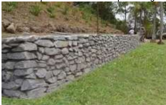
Figura 4: Contenção de alvenaria de pedra argamassada.
