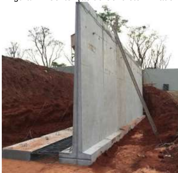
Figura 11: Contenção de Concreto Armado.
