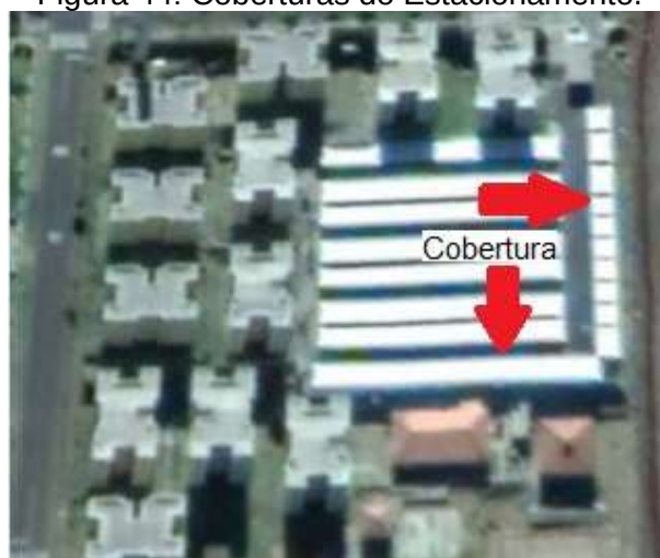
Figura 44: Coberturas do Estacionamento.
