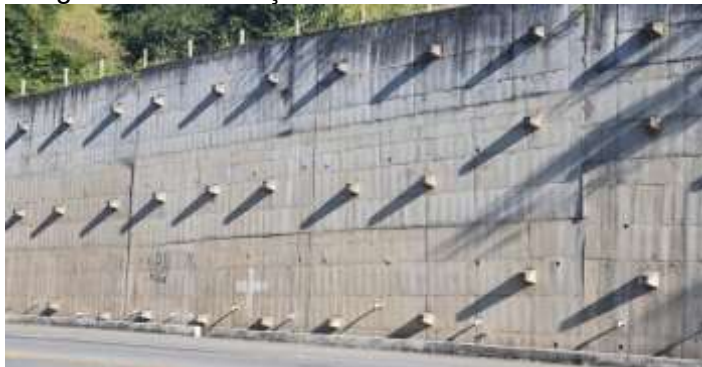
Figura 15: CONTENÇÃO COM USO CORTINA ATIRANTADA.
