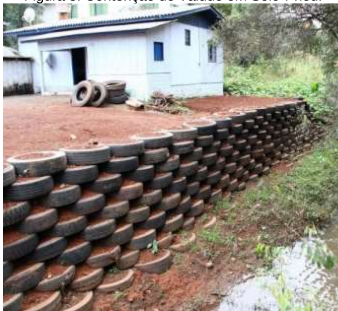
Figura 8: CONTENÇÃO DE TALUDE EM SOLO-PNEU.
