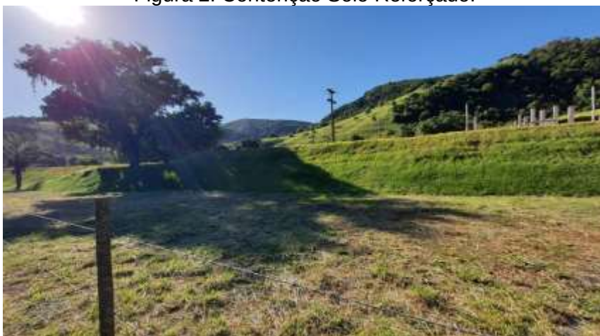
Figura 2: Contenção Solo Reforçado.
