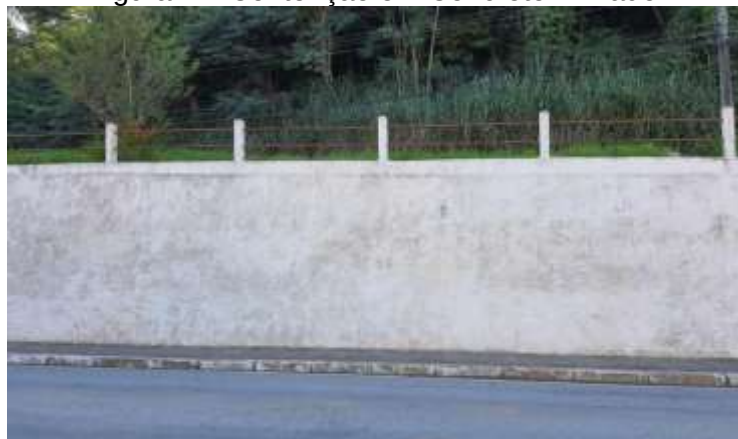
Figura 12: Contenção em Concreto Armado.
