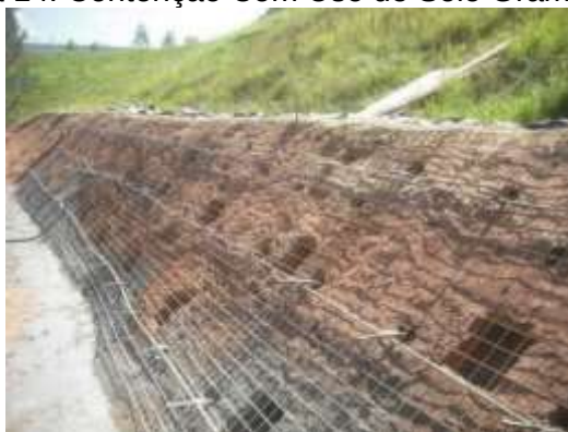
Figura 14: Contenção Com Uso de Solo Grampeado.
