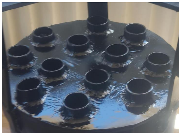
Figura 61 - Aplicação da camada de proteção no tampo inferior Fonte: Acervo Pessoal, 2022
