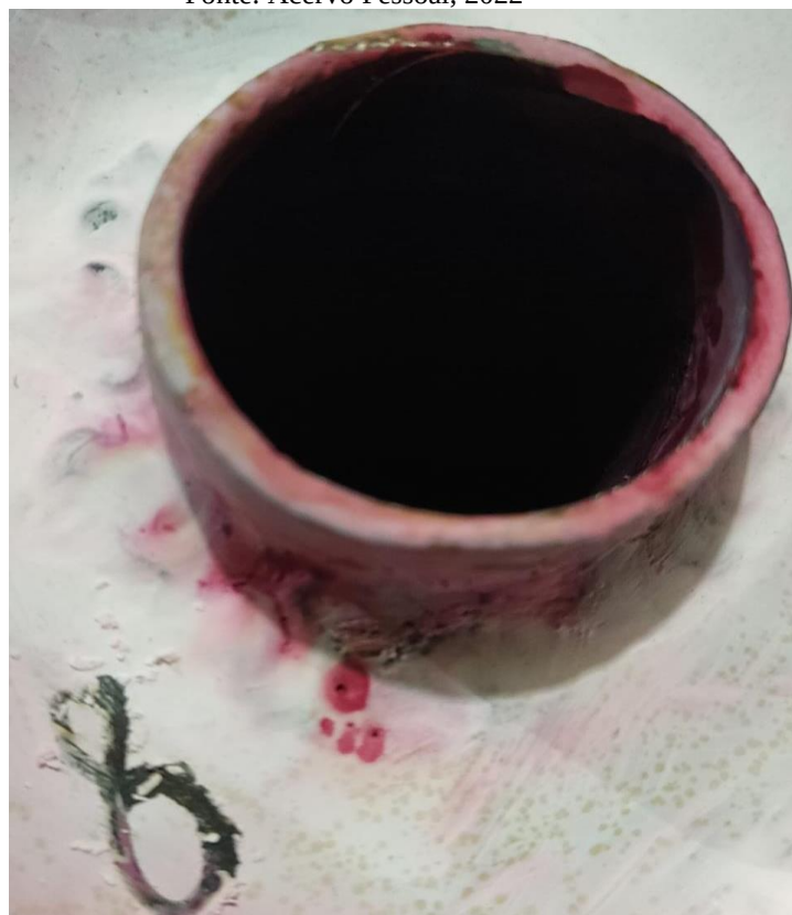
Figura 49 - Imperfeição no contorno da solda do tubo 08 no tampo inferior. Fonte: Acervo Pessoal, 2022
