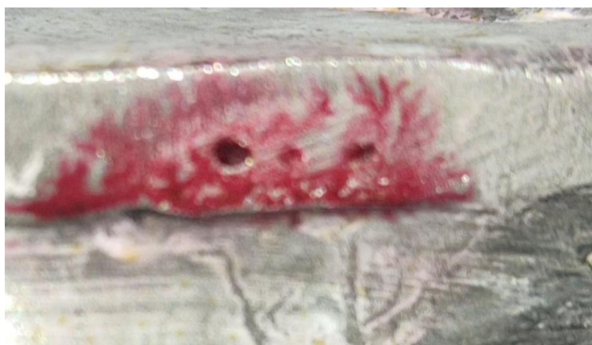
Figura 41 - Imperfeição no contorno da solda no tampo superior. Fonte: Acervo Pessoal, 2022
