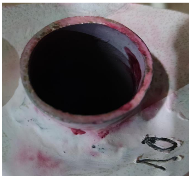
Figura 51 - Imperfeição no contorno da solda do tubo 10 no tampo inferior. Fonte: Acervo Pessoal, 2022
