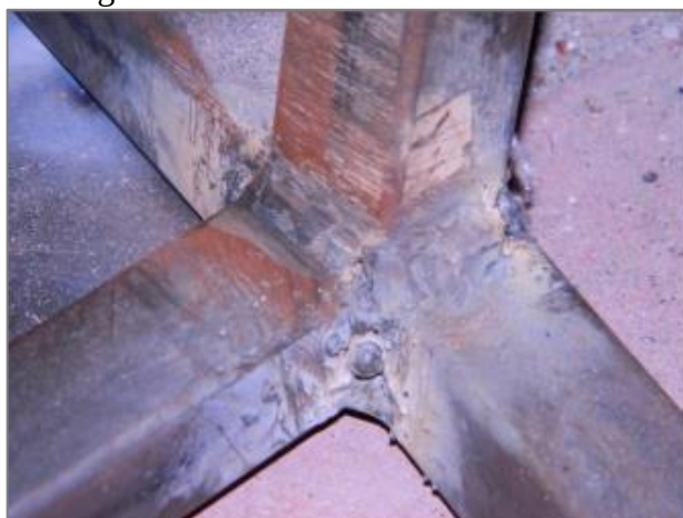
Figura 10: Solda em estrutura metálica.
