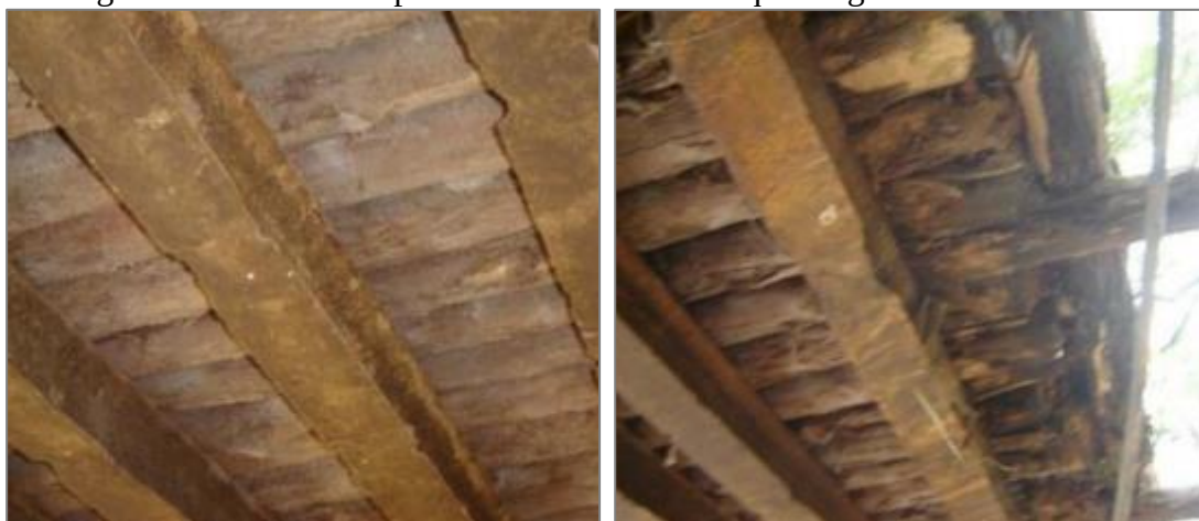
Figuras 14 e 15: Ponte próximo a estrada de Joaquim Egídio em São Paulo.
