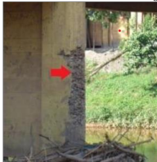
Figura 04: Processo de abrasão da Ponte Governador Magalhães Pinto – MG.
