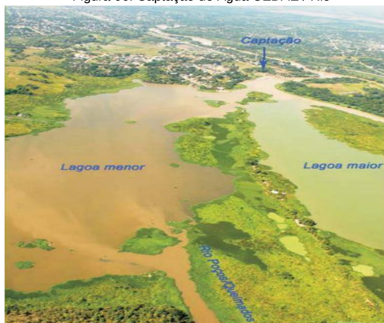
Figura 06: Captação de Água CEDAE / Rio
