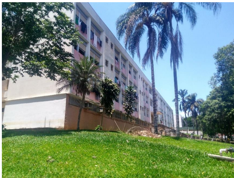
Figura 3: Vista lateral da fachada do edifício
