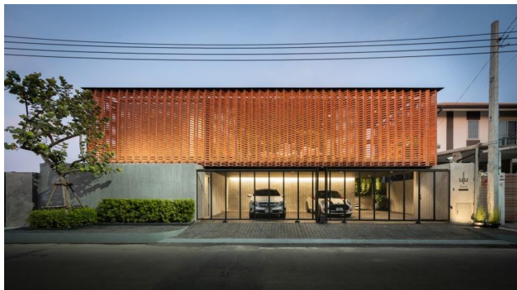
Figura 42: Fachada frontal Residência Sleepless
