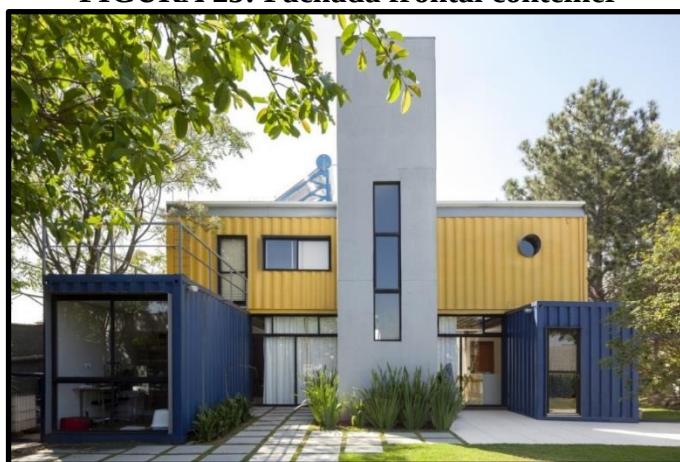
FIGURA 25: Fachada frontal contêiner
