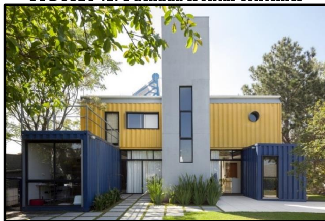
FIGURA 41: Fachada frontal contêiner
