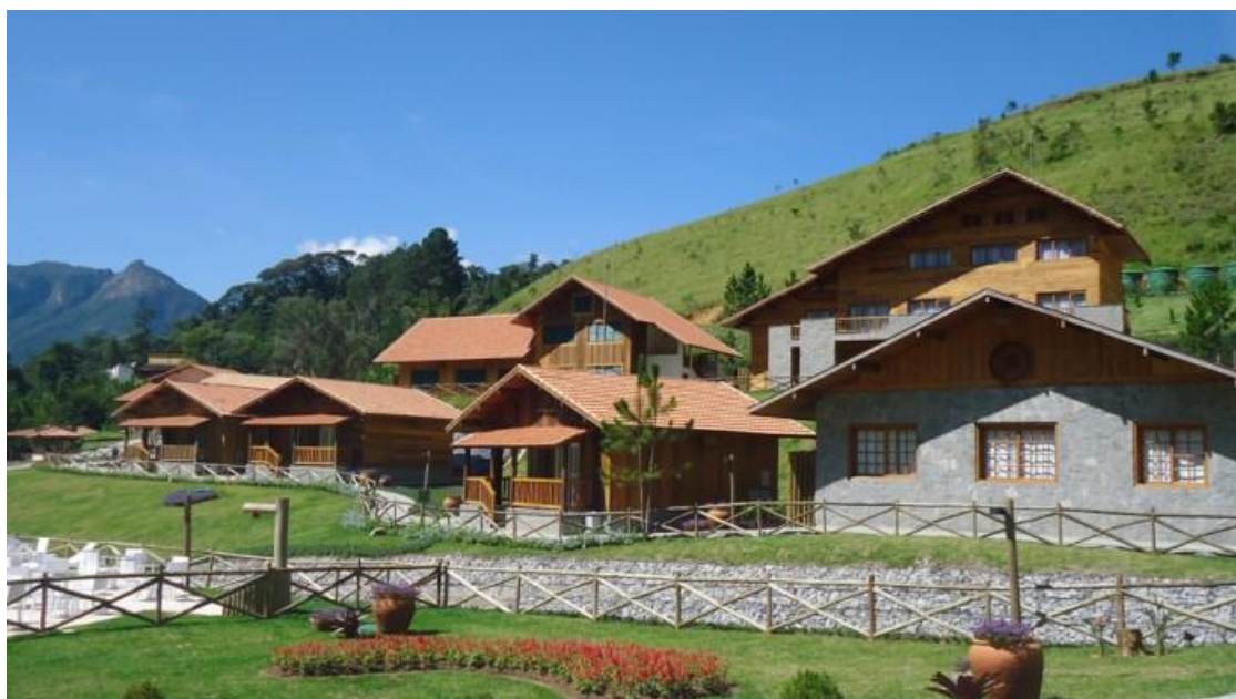
Vista das instalações
