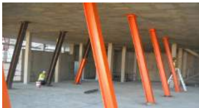
Edificação com perfis inclinados
