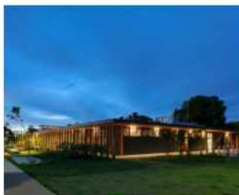
Figura 7 - Refeitório canuanã, vista externa (FONTE: ARCHDAILY 2023)
