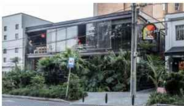
Figura 4 - Restaurant Ilforno, vista fachada (FONTE: ARCHDAILY 2013)
