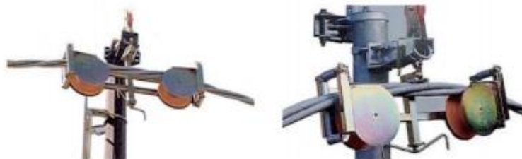
Figura 32 – Roldanas múltiplas para a rede Elicord
