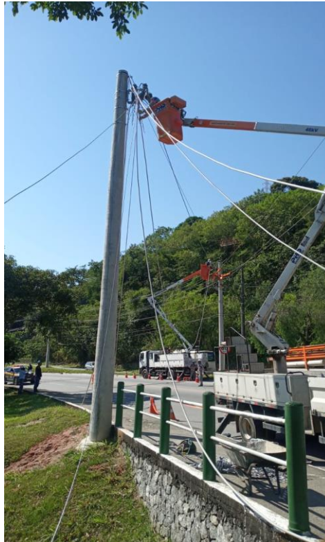
Figura 25 – Instalação de rede aérea compacta no centro de Angra dos Reis
