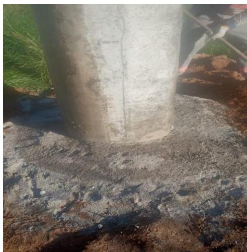
Figura 29 – Concretagem dos postes que receberão a rede Elicord
