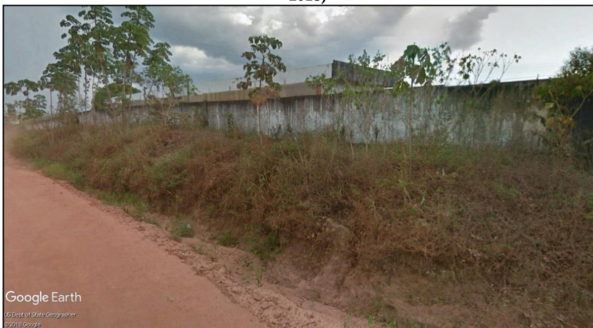
Figura 107 - Terreno proposto fachada, Rua Presidente Dutra (GOOGLE EARTH, 2018)
