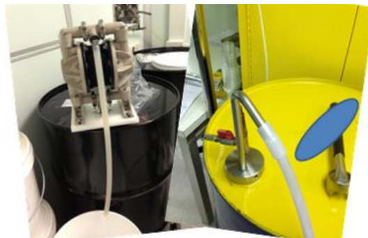
Figura 19: Adaptar nos galões de álcool bombas pneumática para evitar vazamentos. Fonte: Autor, 2015
