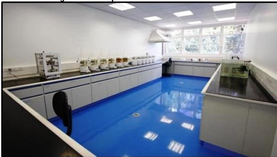
Figura 72: Piso para Laboratório Autonivelante
