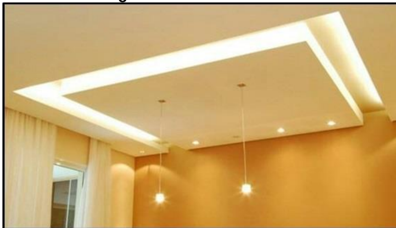
Figura 64: Forro de Gesso
