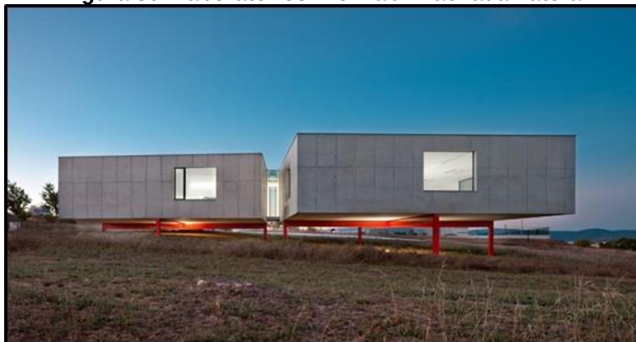
Figura 30: Laboratórios Biokilab - Fachada Lateral
