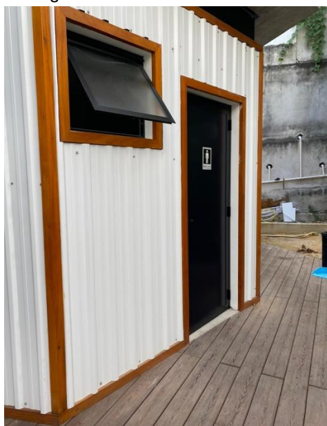
Figura 78: Exterior do banheiro.
