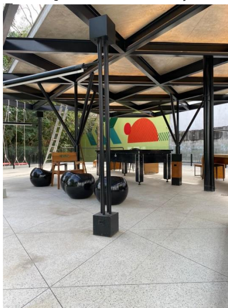
Figura 77: Vista do terraço.
