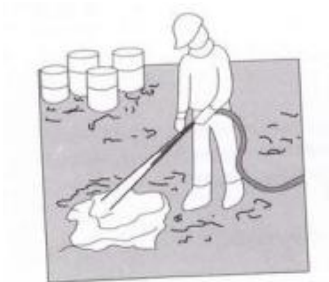
Figura 32: Lavagem com solução alcalina
