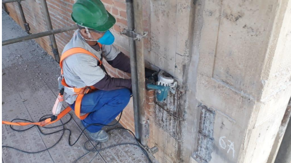
Figura 24 Lixamento elétrico.
