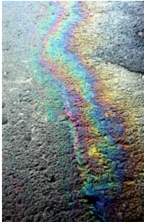
Figura 30: Remoção de óleos e graxas impregnados
