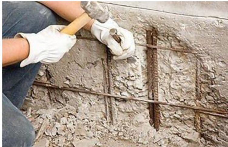
Figura 19: Escarificação manual
