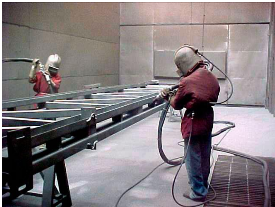
Figura 27: Jato de areia seco ou úmido.
