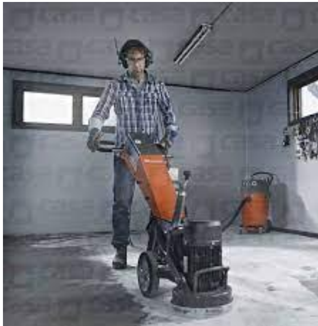
Figura 31: Máquina de desbaste superficial
