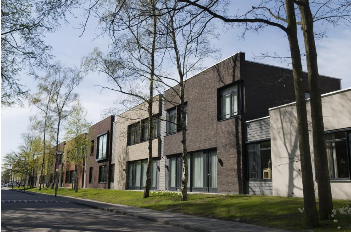
Figura 09 – Fachada das residências
