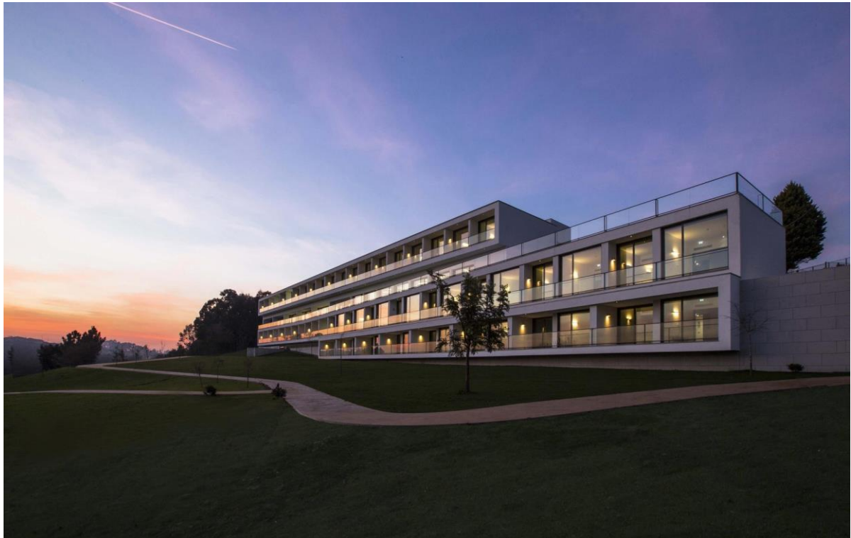
Figura 33 – Imagem da Fachada
