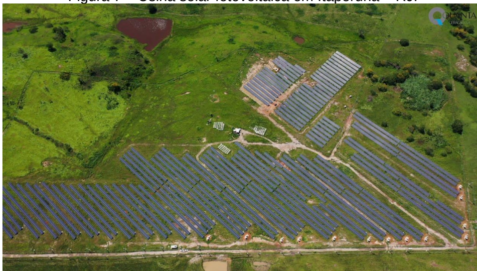
Figura 7 – Usina solar fotovoltaica em Itaperuna – RJ.
