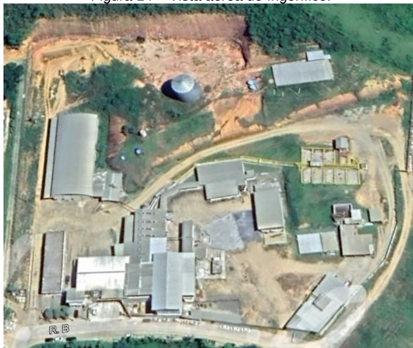
Figura 14 – Vista aérea do frigorífico.
