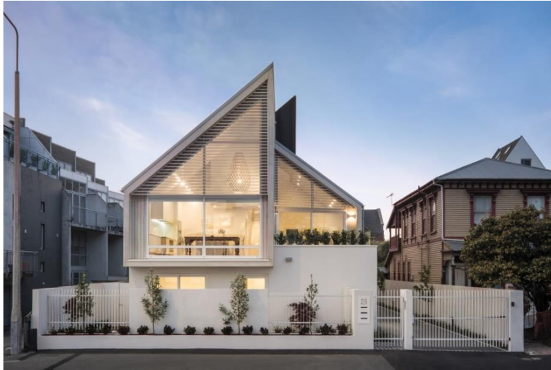
Figura 33- Apartamentos Salisbury Street
