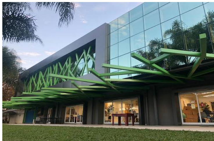
Figura 08 - Fachada prédio ensino fundamental
