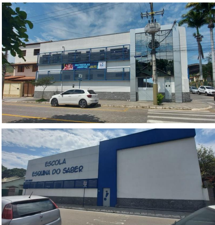
Figura 37- Fachadas Escola Esquina do Saber
