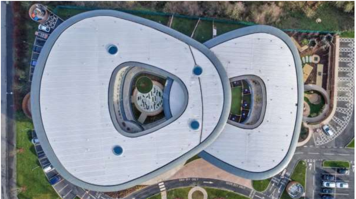
Figura 8: Vista do telhado, Centro Internacional Infantil de Caudwell.
