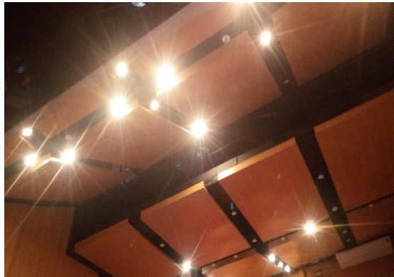
IMAGEM 8: Teto do teatro (Iluminação por trás de placas de madeira para acústicas) Fonte: Arquivo do autor (2018)
