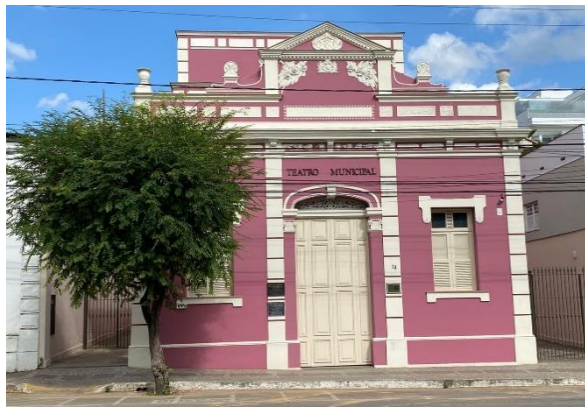
Figura 23 – Fachada do Teatro.
