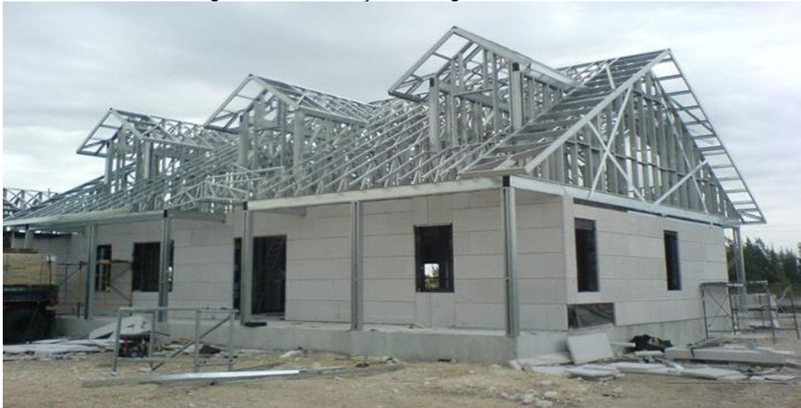
Figura 6 – Construção em Light Steel Frame 1
