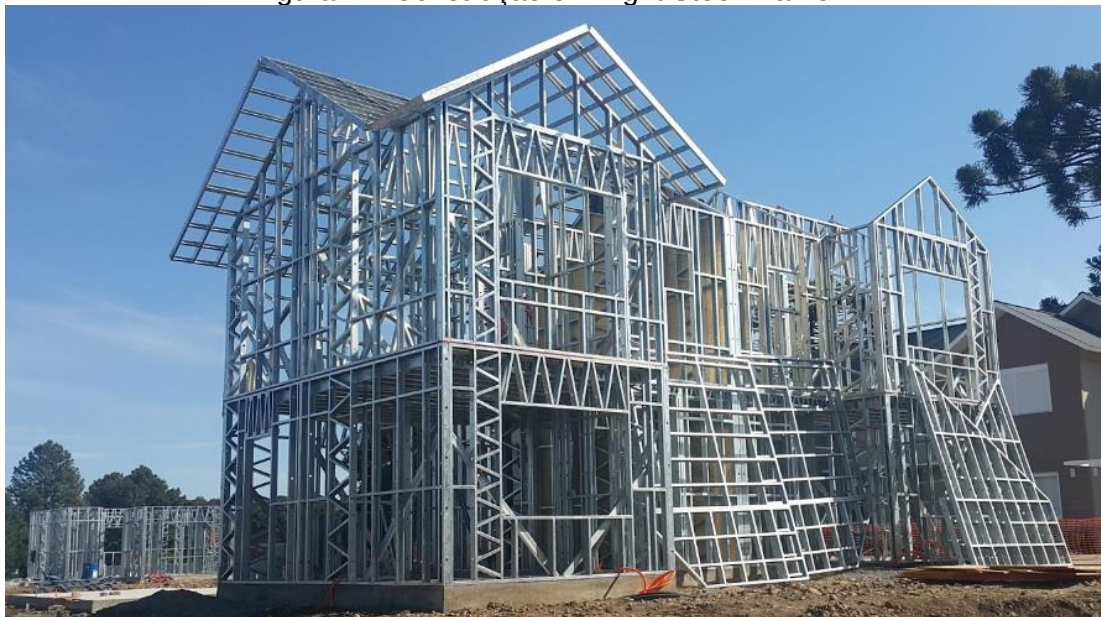
Figura 7 – Construção em Light Steel Frame 2
