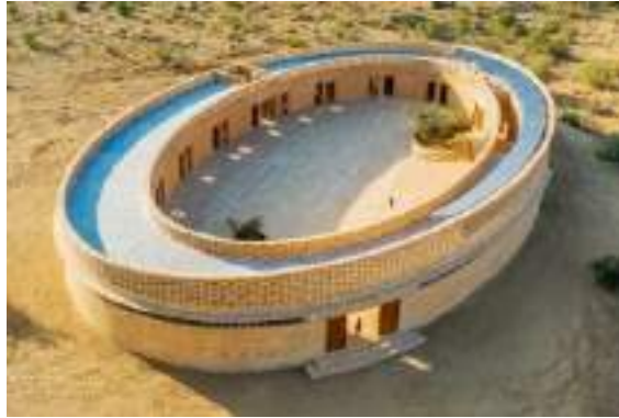
Figura 1 – Fachada da Escola para Garotas Rajkumari Ratnavati Fonte: (ARCHDAILY, 2021)
