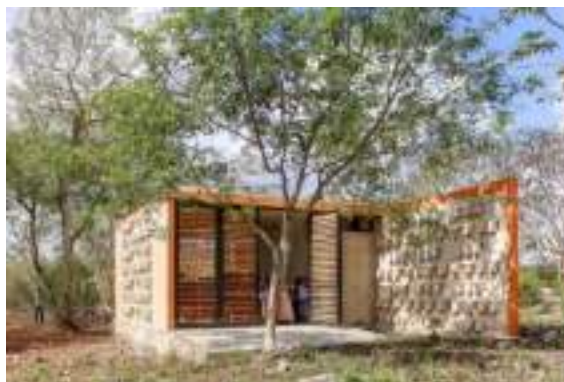
Figura 2 – Fachada do Parque da Ciência Fonte: (ARCHDAILY, 2021)
