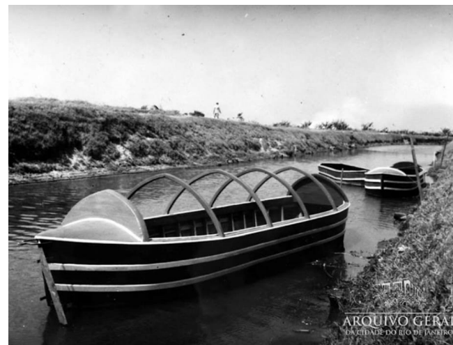
Figura 6 - Canal da Pavuna.
