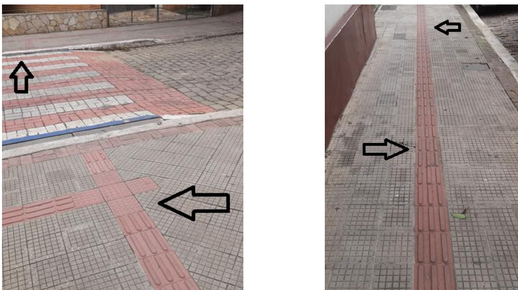
Figura 19 – Calçada Rua Barão de Cotequipe, Centro – Leopoldina - MG.
