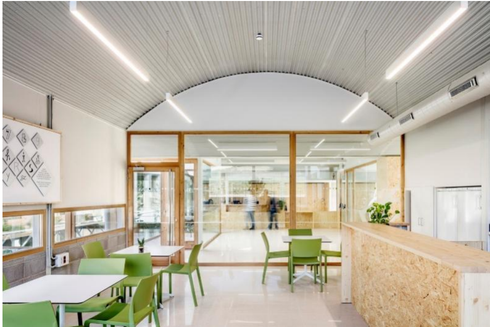
Figura 16 - Interior do pavilhão, com detalhe da estrutura metálica abobadada.
