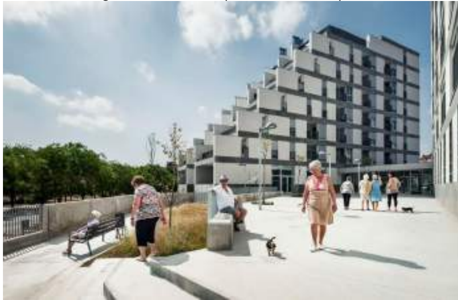
Figura 2 – Residência para de idosos - Espanha
