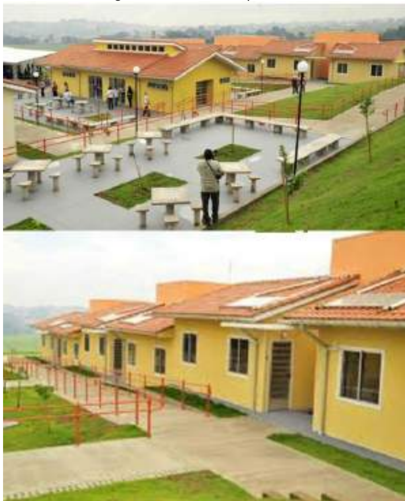
Figura 5 – Condomínio para idoso
