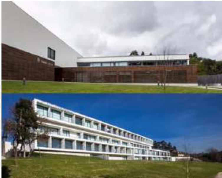
Figura 10 – Fachada Principal e Posterior da Torre Sênior
