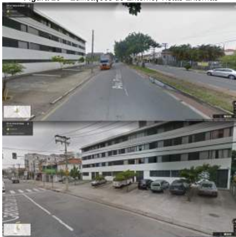
Figura 20 – Edificações do Entorno, Vistas Externas
