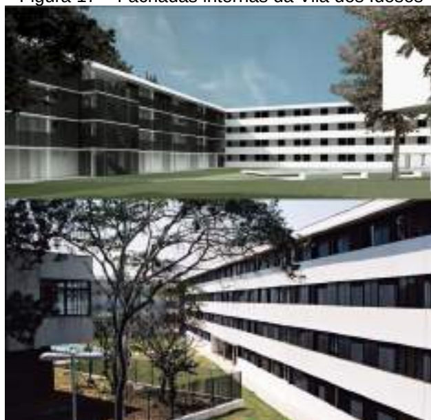
Figura 17 – Fachadas internas da Vila dos Idosos
