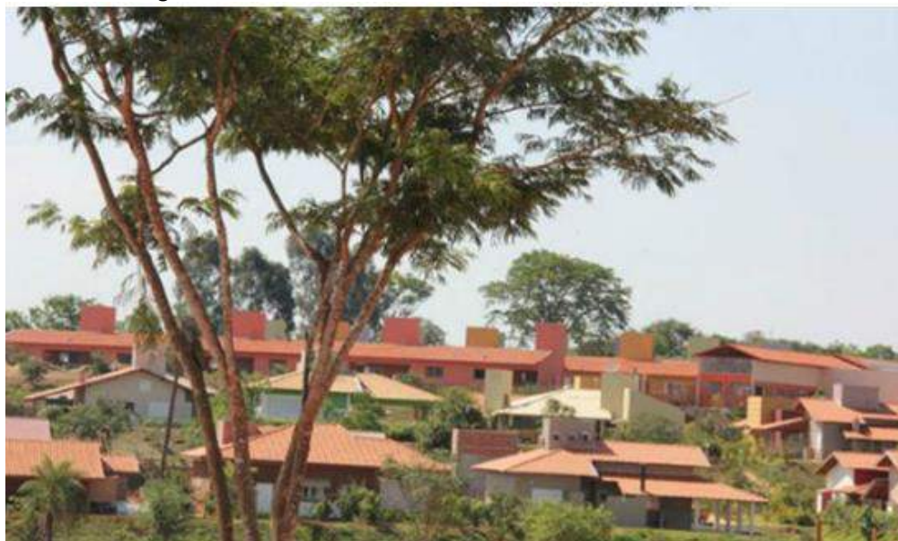
Figura 6 – Condomínio AGERIP, São José do Rio Preto, SP
