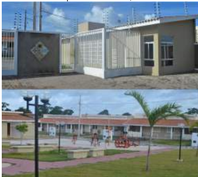
Figura 22 – Fachada Principal e Vista Interna, Condomínio Cidade Madura
