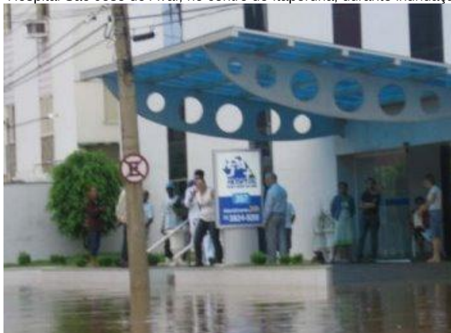
Figura 68- Hospital São José do Avaí, no centro de Itaperuna, durante inundação de 2008.
