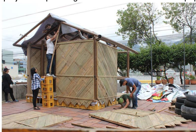
Figura 22- Abrigos projetados por Shigeru Ban utilizando tubos de papelão e engradados
