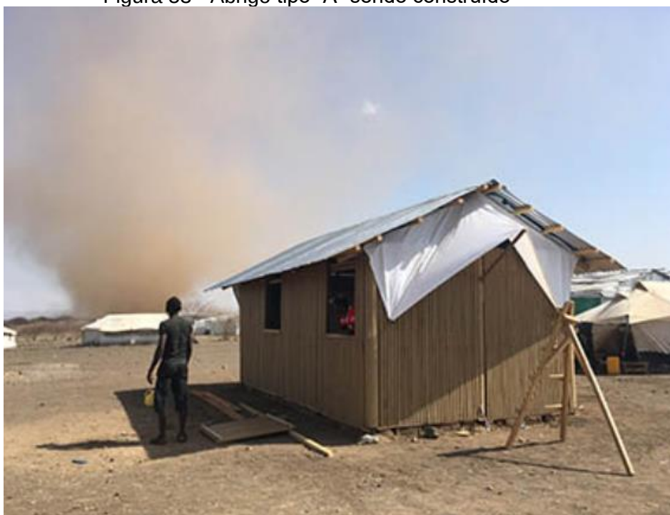
Figura 53- Abrigo tipo “A” sendo construído
