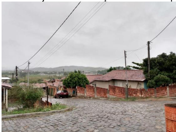
Figura 33- Conjunto de habitação social da Capelinha
